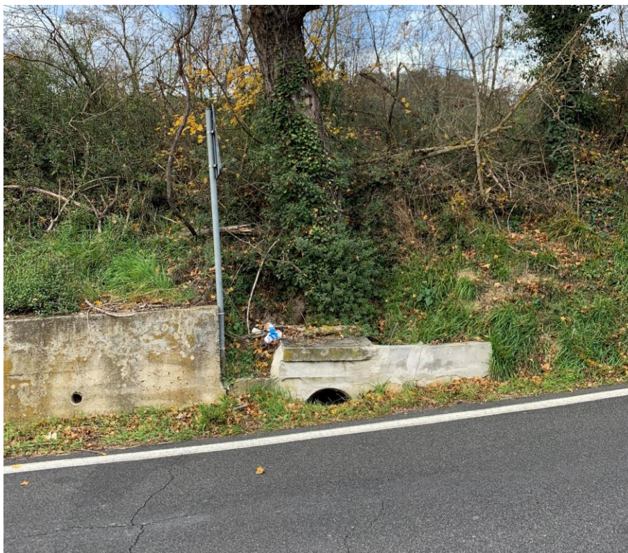
Figura 24 – Pozzetto di raccolta al km 7+400 lato monte
